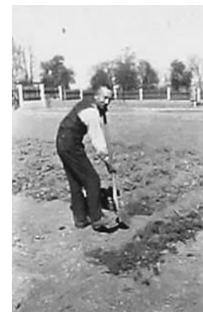
Školník p. Oborný při zemních pracích na budoucí zahradě školy
