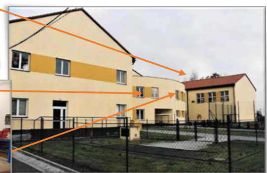
Pavilon kuchyně a jídelny
