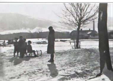
V místech, kam se chodily děti sáňkovat, bylo vyměřeno staveniště.
