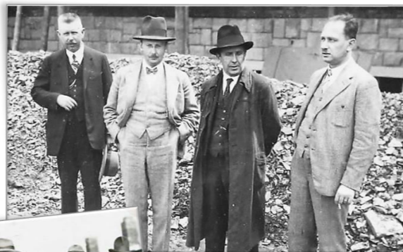
Ing. F. Felkl, ministerský rada Žilka, Ing. R. Kohout a vedoucí stavby J. Fizek při předávání staveniště školy.
