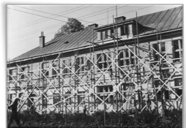
Oprava fasády budovy školy u kostela
