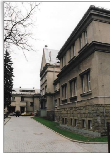
Čelní část budovy bývalé měšťanské školy před rekonstrukcí
